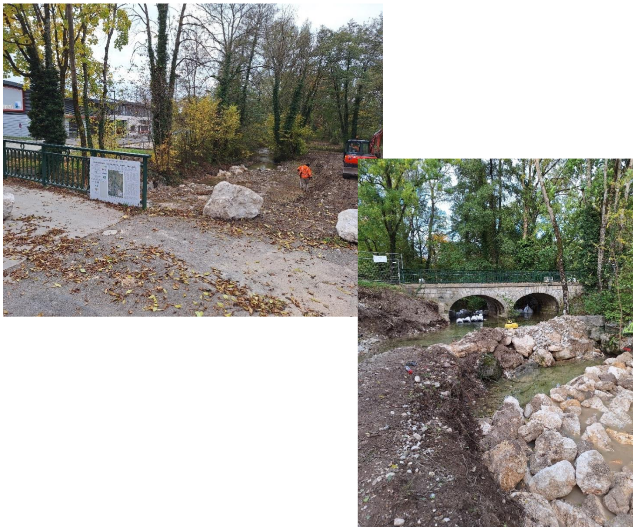
Figure 1 - Travaux de restauration de la continuité écologique en cours (Allondon, été-automne 2024)
