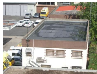
Toiture stockante revêtue Source : Sepia Conseils
