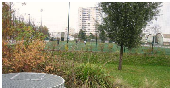
Bassin de stockage et terrain de sport inondable Source : Sepia Conseils
