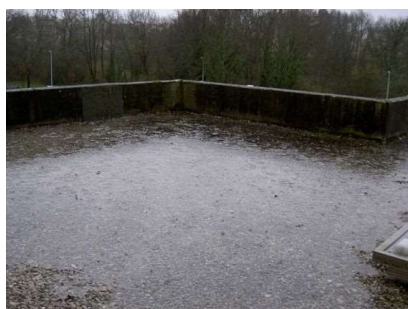
Toiture stockante en graviers par temps de pluie Source : OIEAU
