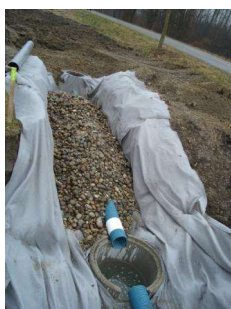
Aménagement d'une structure réservoir sous voirie Source : Samuel Lollier
