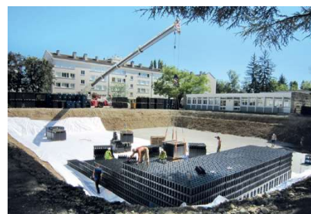
Structure réservoir alvéolaire Source : AERMC
