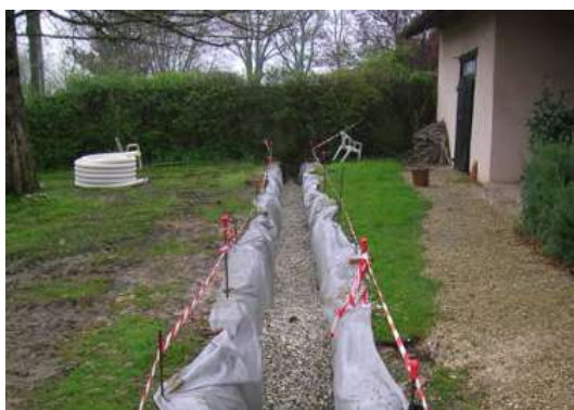
Tranchée en cours de remplissage Source : mts
