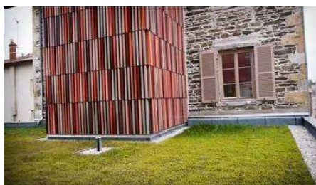
Toiture extensive simple Source : Grand Lyon
