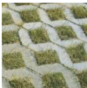
Allée en dalle béton-gazon Source : Pierre et sol
