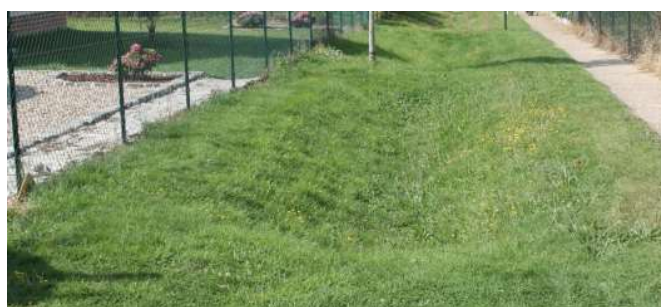
Noue en bordure d'allée Source : Alise Environnement
