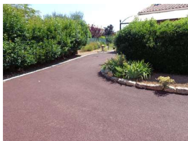
Allée/parking en enrobé poreux Source : Celtivia
