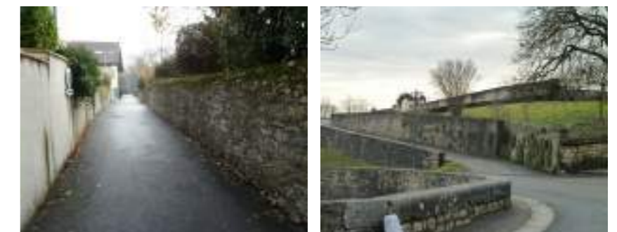
Exemples de murs de clôtures et de soutènements en pierre créant des perspectives et structurant les espaces libres
