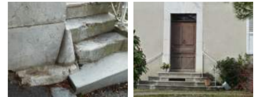
Éléments caractéristiques préservés : emmarchements, perrons, chasse-roues, seuils en pierre...
